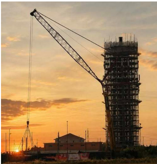
Nichelino dice addio alla grande cisterna della centrale Smat
