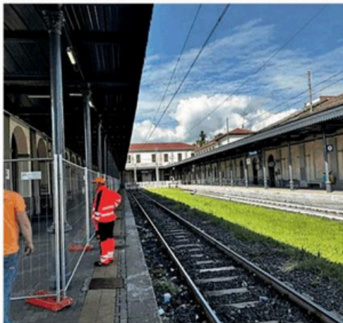
L'inizio dei lavori alla stazione di Pinerolo
