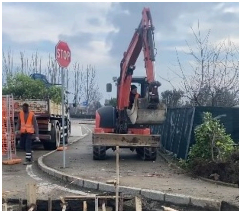
A Nichelino partiti i lavori di riqualificazione di via Prali
