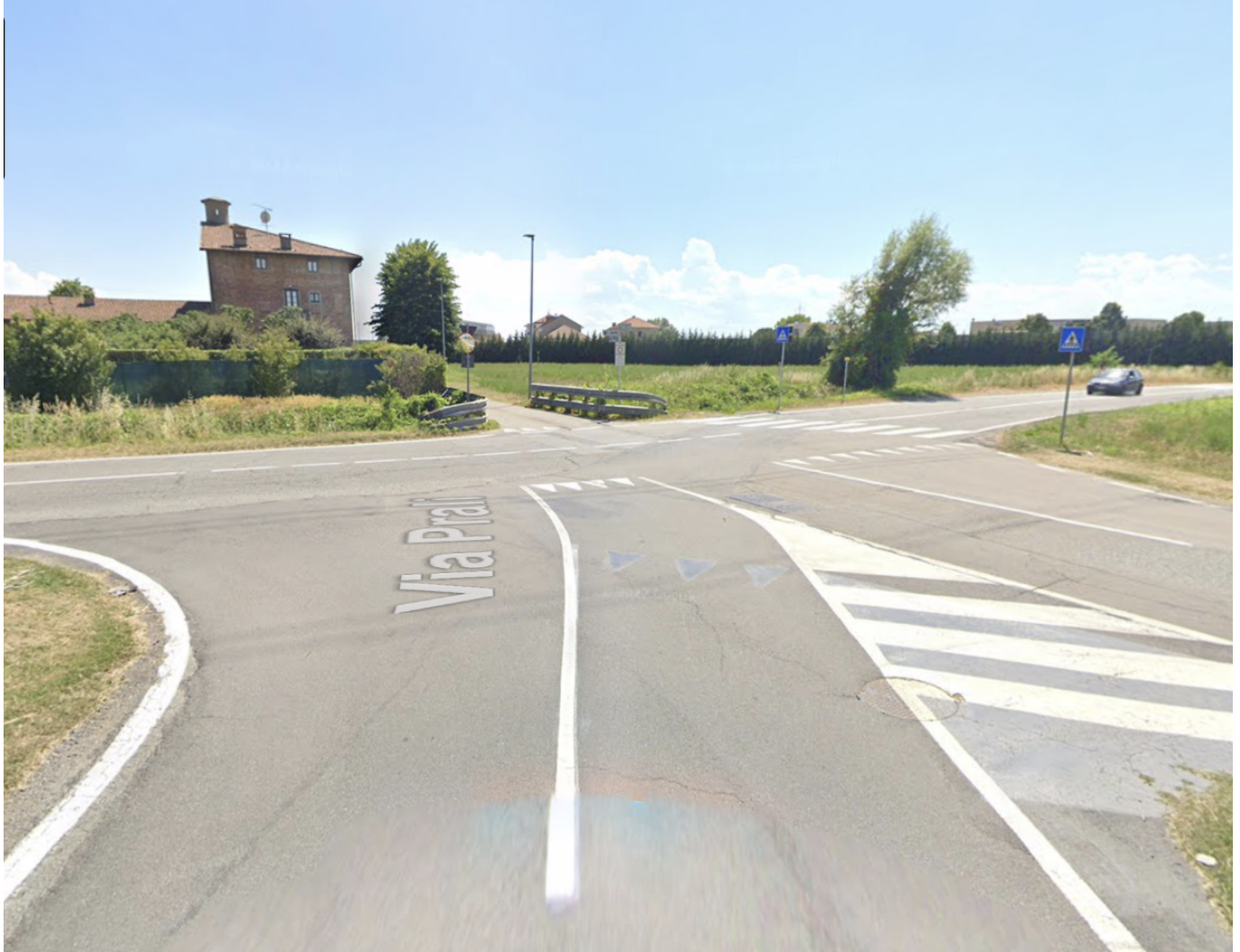
A Nichelino sono iniziati i lavori di riqualificazione di via Prali, con un intervento che include la realizzazione di una nuova rotonda e opere complementari su viabilità e infrastrutture
