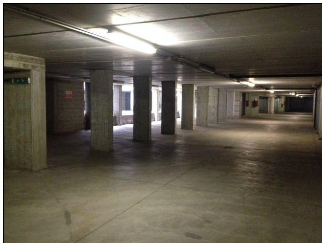
Foto 2 - Via Cagliari 23 Piano Int. -2.
