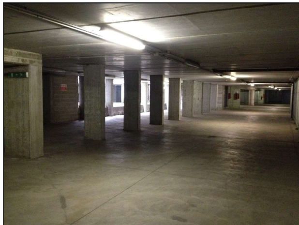
Foto 2 - Via Cagliari 23 Piano Int. -2.
