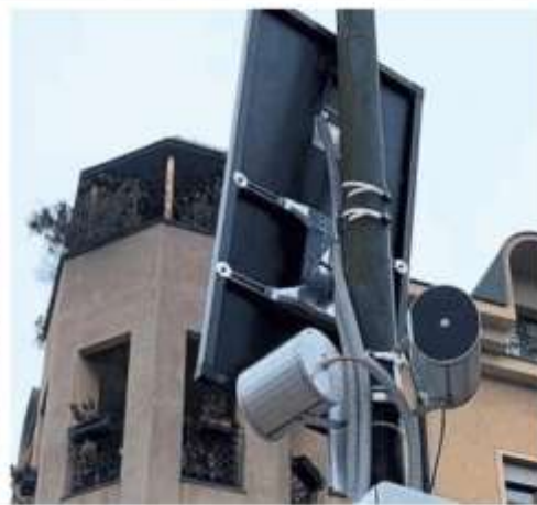
I diffusori per la filodiffusione montati agli incroci
