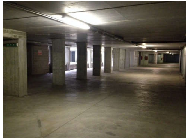
Foto 2 - Via Cagliari 23 Piano Int. -2.
